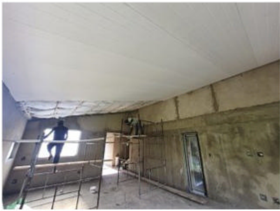
Isolering en IsoBoard-plafonne word geïnstalleer.
