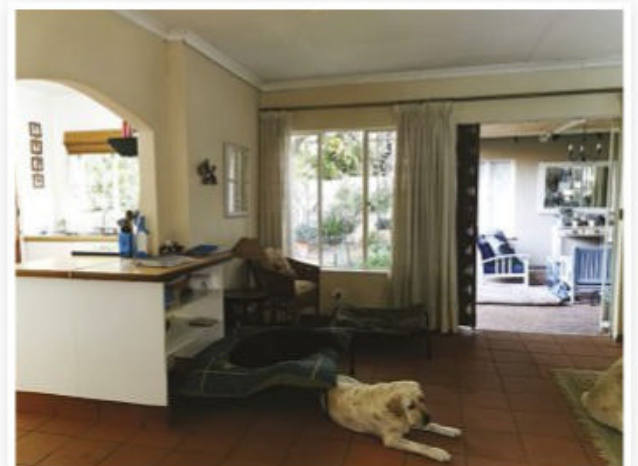
Vier vensters en 'n dubbeldeur na die stoep is uitgehaal en vervang met twee aluminiumraam-skuifvensters en 'n stapeldeur met vyf panele.
