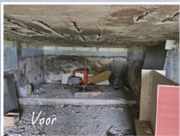
Die swembad was met ’n betonblad bedek en as opbergplek gebruik.
