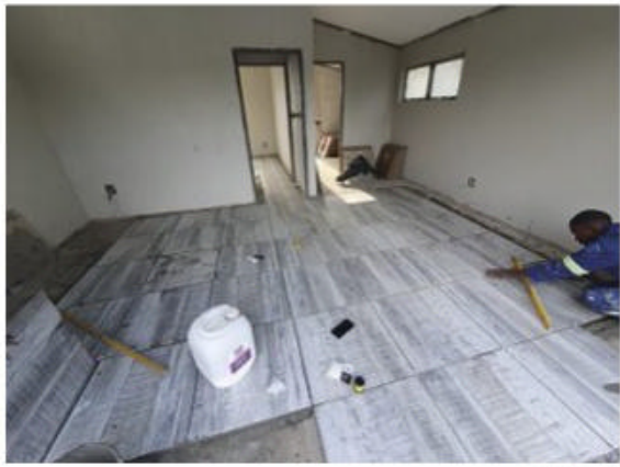
Vloerteëls is gelê en die trap ingesit. Net soos by 'n baksteen-huis kan polistireenmure geteël word, soos Andrew in die badkamers gedoen het.
