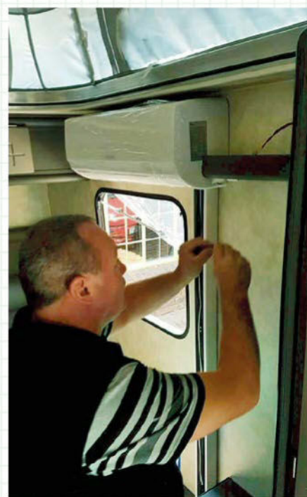
MAAK SEKER. Kry 'n ervare installeerder om jou wa se lugversorger vir jou in te bou.
