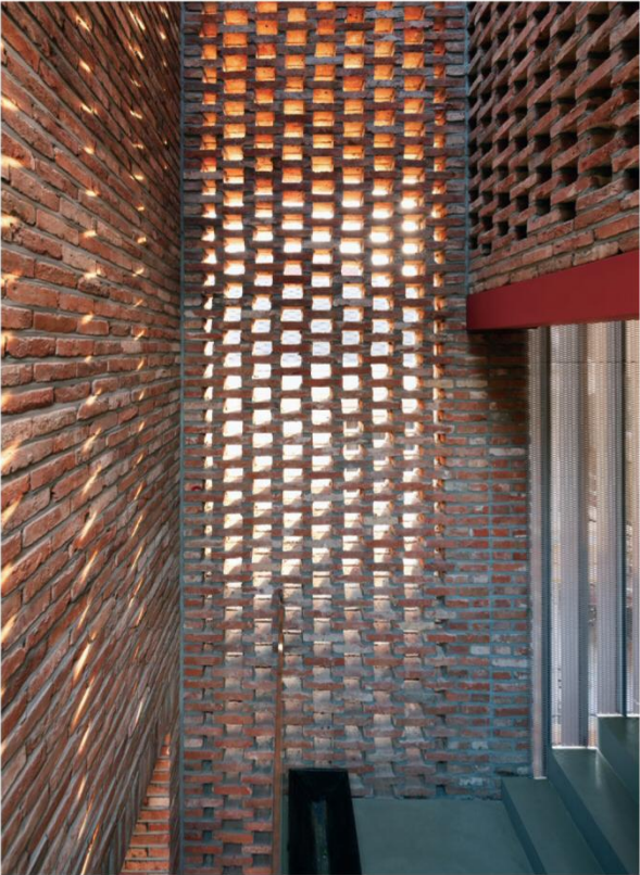
띄어쌓기 된 벽돌 면을 통해 빛이 산란된다. The light is scattered by perforated brick walls.
