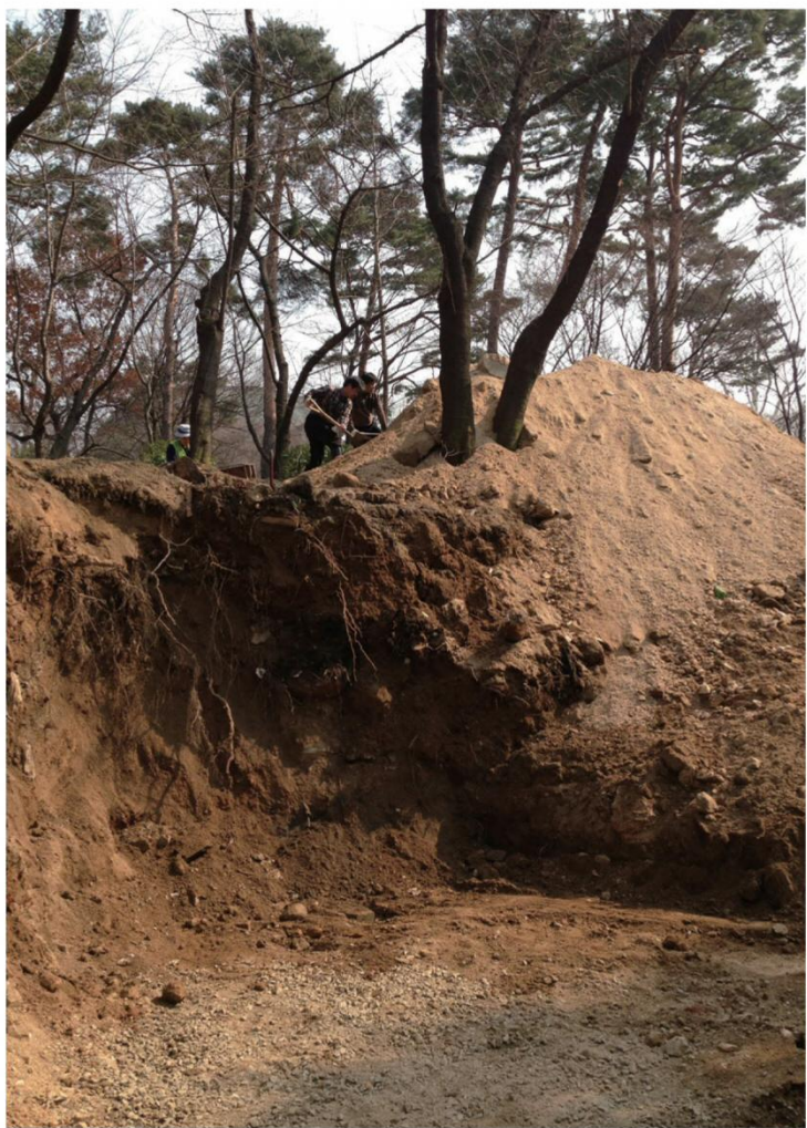
삼청공원 숲속도서관 공사 모습 Construction view of the Samcheong Forest Library
