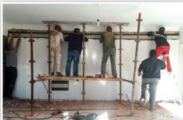
Dit het ses sterk manne gekos om ’n stutbalk van beton in te sit sodat hulle ’n opening van 6 m in wat nou die oopplan-kombuis-en-leefarea is, kon bewerkstellig.
