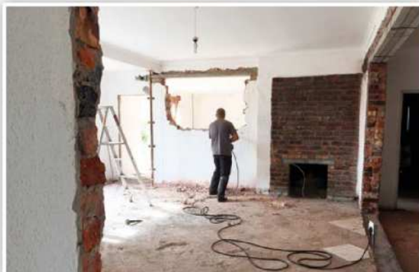
Anwar het ’n hamerboor gebruik om dié muur uit te kap; dit het die ruimte tussen die sitkamer en die slaapkamer oopgemaak en ’n sit-studeerkamer geskep.
